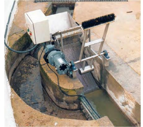
El limpiarejas modelo RC-01 es una maquina de diseño sencillo, que incluye la reja filtrante de barrotos curvados y un brazo giratorio que soporta normalmente dos peines de limpieza. Su uso es adecuado para canales anchos o estrechos de poca profundidad.
